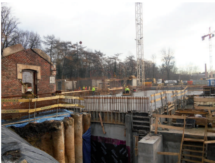
19. Budowa nowej siedziby Archiwum Narodowego w Krakowie, widok ogólny pierwszego piętra od strony zachodniej, w głębi budynek „twierdzy Kraków” nr 47 – przyszłe pomieszczenie gospodarcze przy nowym obiekcie. Stan na 8 grudnia 2017 r. (fot. ECM Group Polska S.A.)
