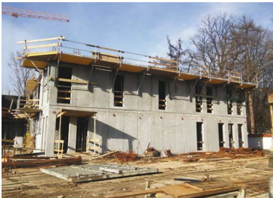
21. Budowa nowej siedziby Archiwum Narodowego w Krakowie. Widok segmentu biurowego od strony wschodniej, stan ze stycznia 2018 r. (fot. Paweł Ząbczyński)
