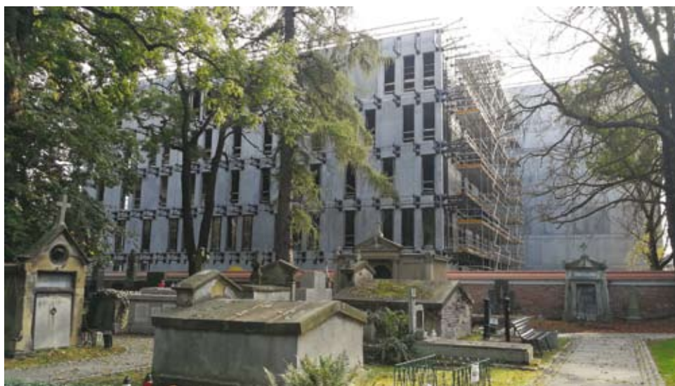
22. Budowa nowej siedziby Archiwum Narodowego w Krakowie. Widok na północną fasadę budynku od strony Cmentarza Rakowickiego, stan z września 2018 r. (fot. Paweł Ząbczyński)
