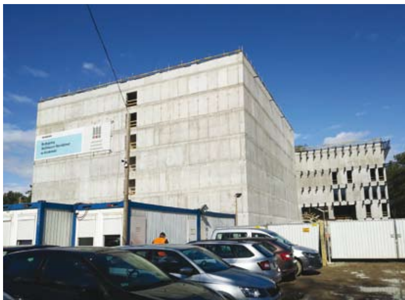
24. Budowa nowej siedziby Archiwum Narodowego w Krakowie. Widok na budynek od strony południowej, stan z października 2018 r. (fot. Paweł Ząbczyński)
