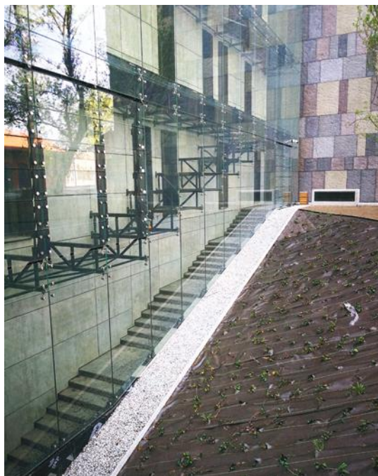
55. Budowa nowej siedziby Archiwum Narodowego w Krakowie. Świeżo zasadzona zielen przed wejściem zewnętrznym do auli, stan z kwietnia 2020 r. (fot. Paweł Ząbczyński)
