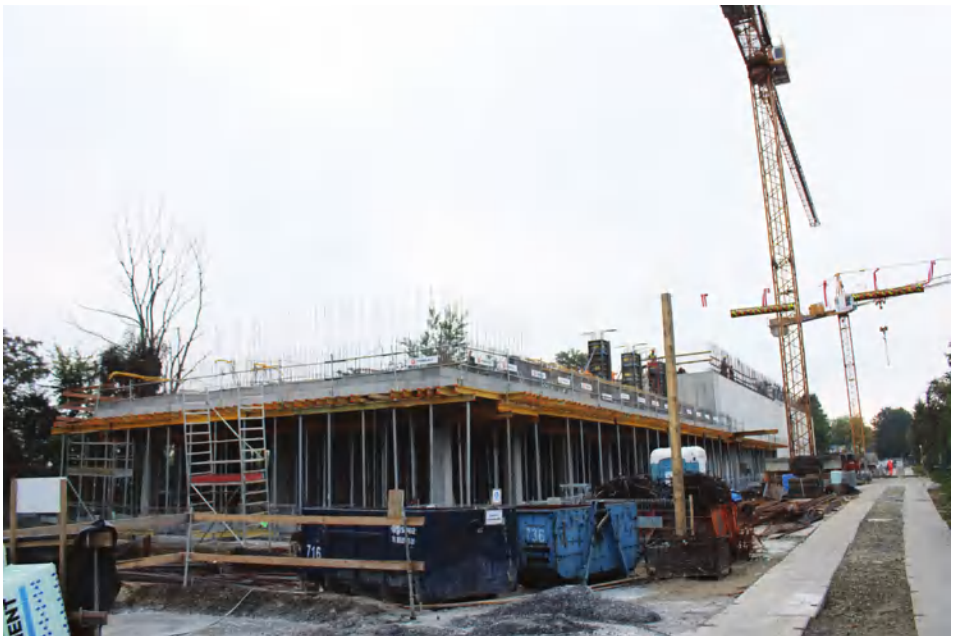
22. Budowa nowej siedziby Archiwum Narodowego w Krakowie Oddział w Nowym Sączu. Postęp robót budowlanych, stan z 29 września 2021 r. (fot. Sylwester Rękas)
