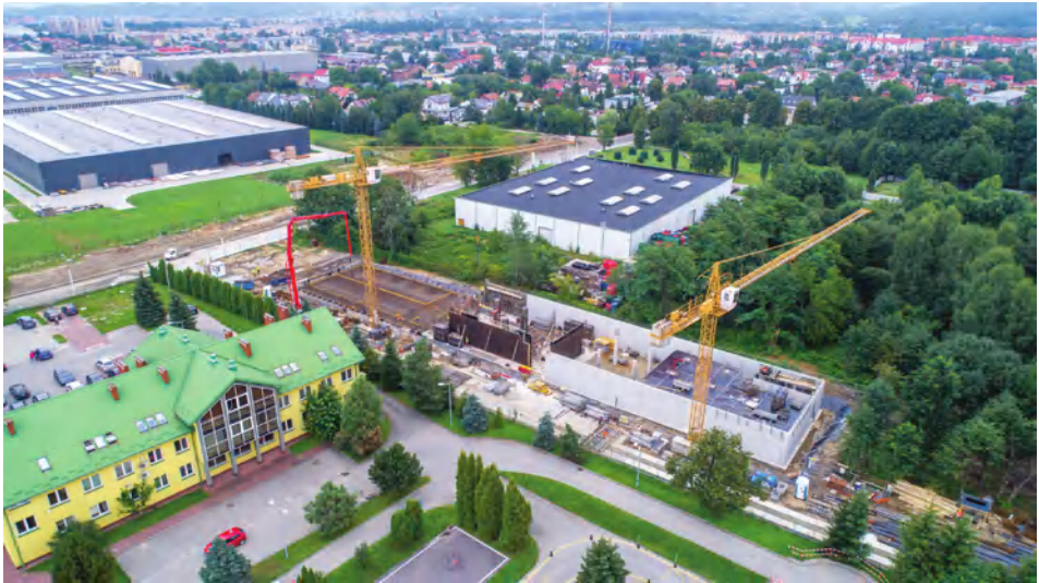
21. Budowa nowej siedziby Archiwum Narodowego w Krakowie Oddział w Nowym Sączu. Postęp robót budowlanych, stan z 10 sierpnia 2021 r. – widok z drona (fot. Stahadron Stanisław Jabłoński)
