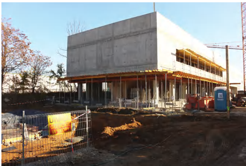
23. Budowa nowej siedziby Archiwum Narodowego w Krakowie Oddział w Nowym Sączu. Widok od frontu (od strony ul. 29 Listopada), stan z 10 listopada 2021 r. (fot. Sylwester Rękas)
